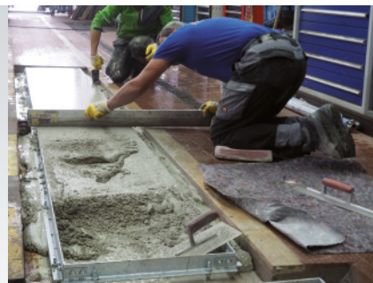
Bild: Einbau Fundamentrahmen
